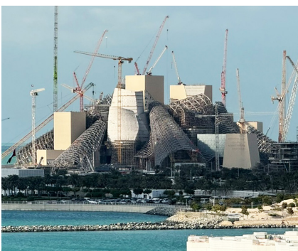
Guggenheim Museum im Bau.
