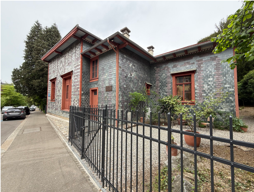
Ehemaliges Atelier von Arnold Böcklin an der Bocklinstrasse 17 in Zürich. Die Schieferplatten am Haus mussten im Auftrag der Feuerpolizei angebracht werden. Unten der Innenraum mit den schwarzen Jutewänden und den grünen Streifen. Diese sind nicht mehr original - sie wurden im Rahmen einer Restauration in den ursprünglichen Zustand gebracht.
